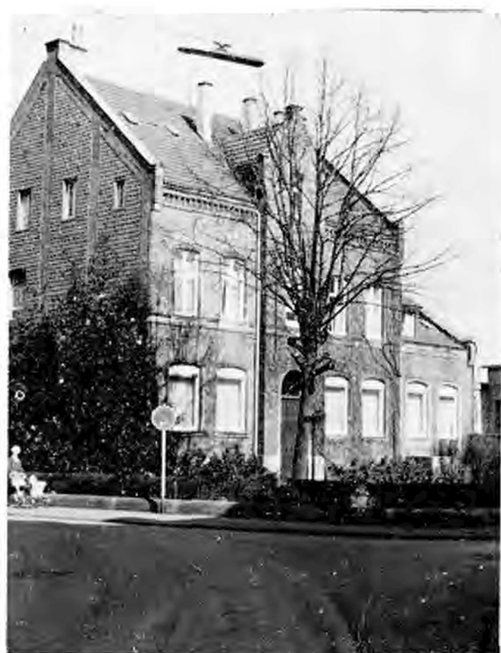
Die ehemalige 1874 erbaute Provinzial-Taubstummenanstalt der Rheinprovinz in Brühl, Schützenstraße, Ecke Friedrichstraße
